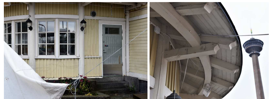
Kuva: Koillispäädyn pyöreässä osassa on uudet ikkunat.
