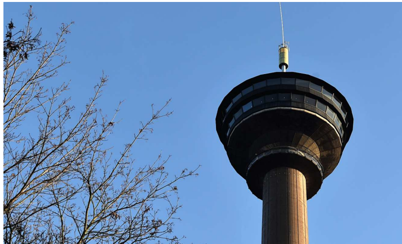
Kuva: Näsineulan tornin jalka rakennettiin liukuvaluna, ravintolaosa lautamuottivaluna.
