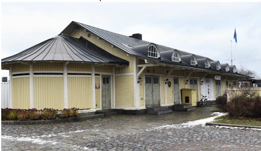
Kuva: Makasiinin ulkoasussa on käytetty listakoristelua ja vaaka- ja pystylaudoitusta horisontaalisissa vyöhykkeissä. Julkisivujen jäsentelyperiaate noudattaa alkuperäistä sisätilajakoon. Isot lapeikkunat toivat luonnonvaloa varastohuoneisiin
