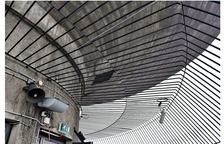
Kuva: Nasinneulan ulkotasanne, jonka metallihäkki on tehty jälkeinpäin.
