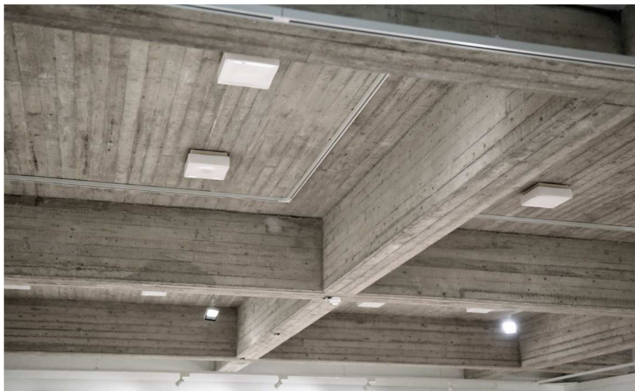
Kuva: Sisätiloissa on paljon laajoja lautamuottipintaisia betonirakenteita, kuten kattopalkistot.
